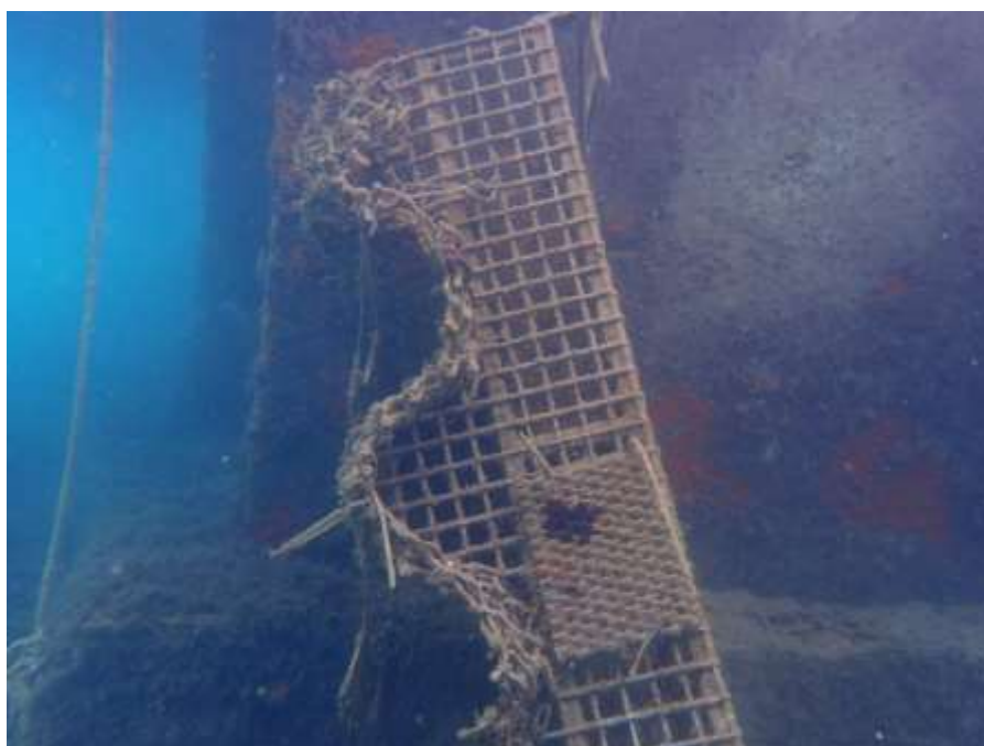
Imagen 7: Unidad 10007 sujetándose únicamente por un cabo.
