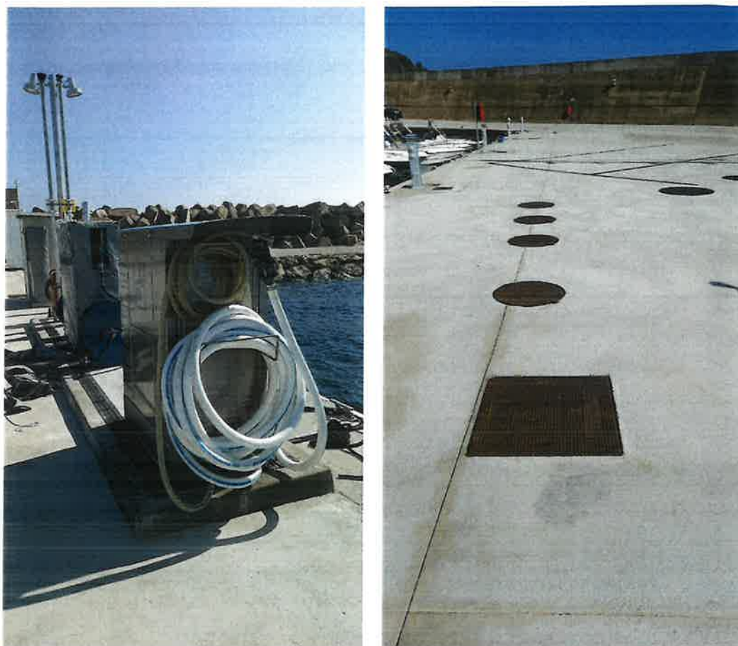
Imatge de la màquina aspirant y el decantador / separador
