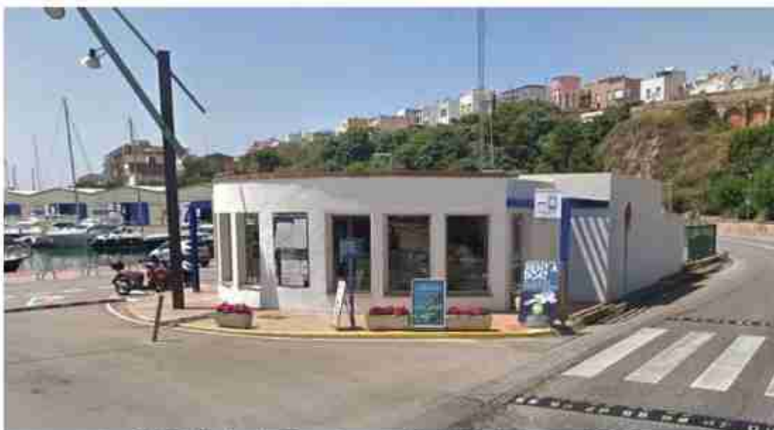
Edifici Capitània. Punt de recepció de l'ajuda externa, i CRA.
