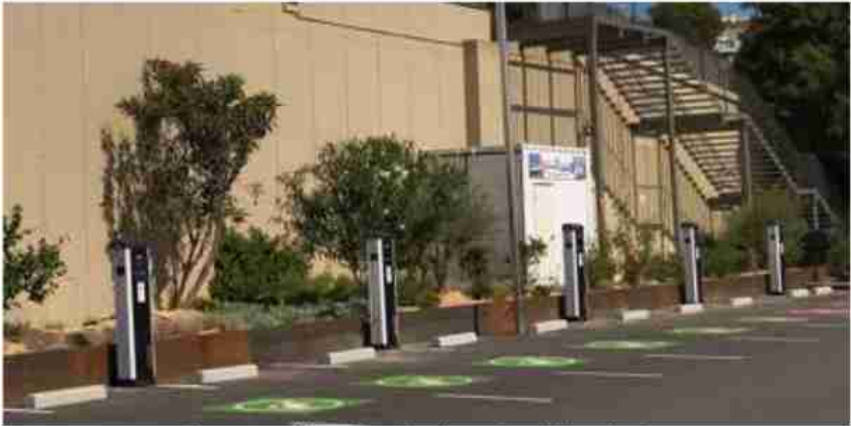
Aparcament Ribera. Punt de càrrega de vehicles elèctrics.
