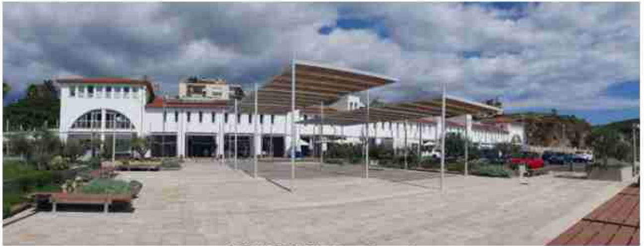
Edifici HORECA. Vista General.
