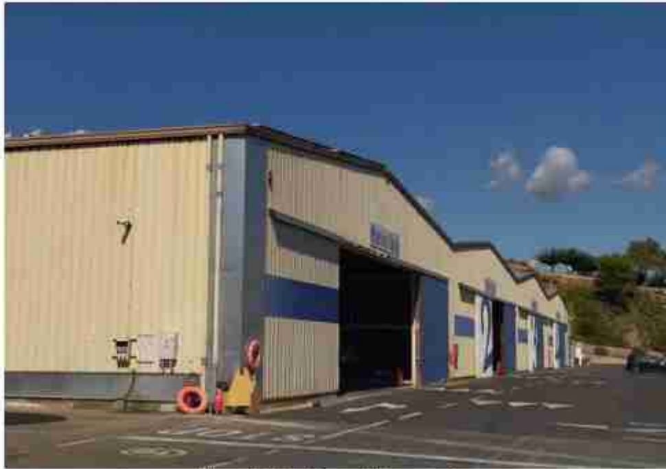
Naus Marina Seca. Vista exterior.
